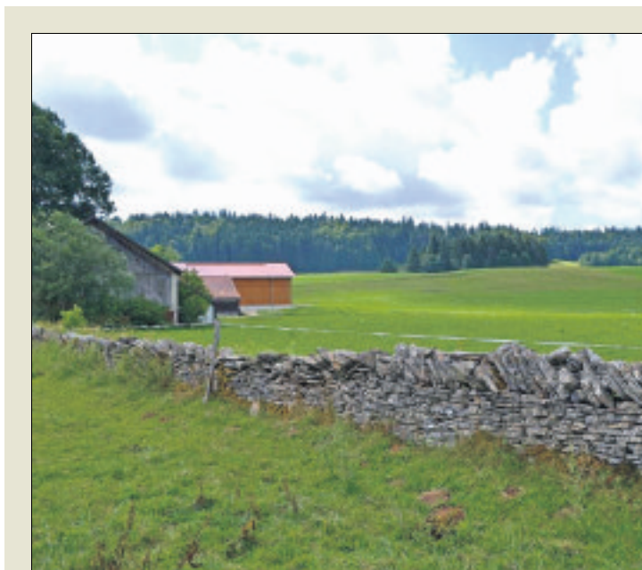
Avant/après. Un mur en pierre sèche d'une septantaine de mètres, au Creux-des-Biches, a été choisi pour un projet pilote de restauration... ARCHIVES
