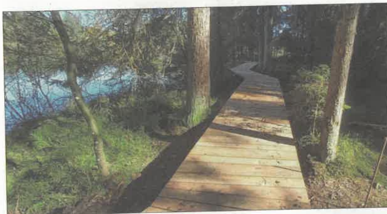
La construction du ponton continu est désormais terminée.
