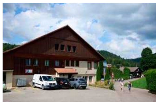
Utilisé principalement comme entrepôt actuellement, le bâtiment nécessite une rénovation d'ensemble. ARCHIVES DAVID MARCHON
