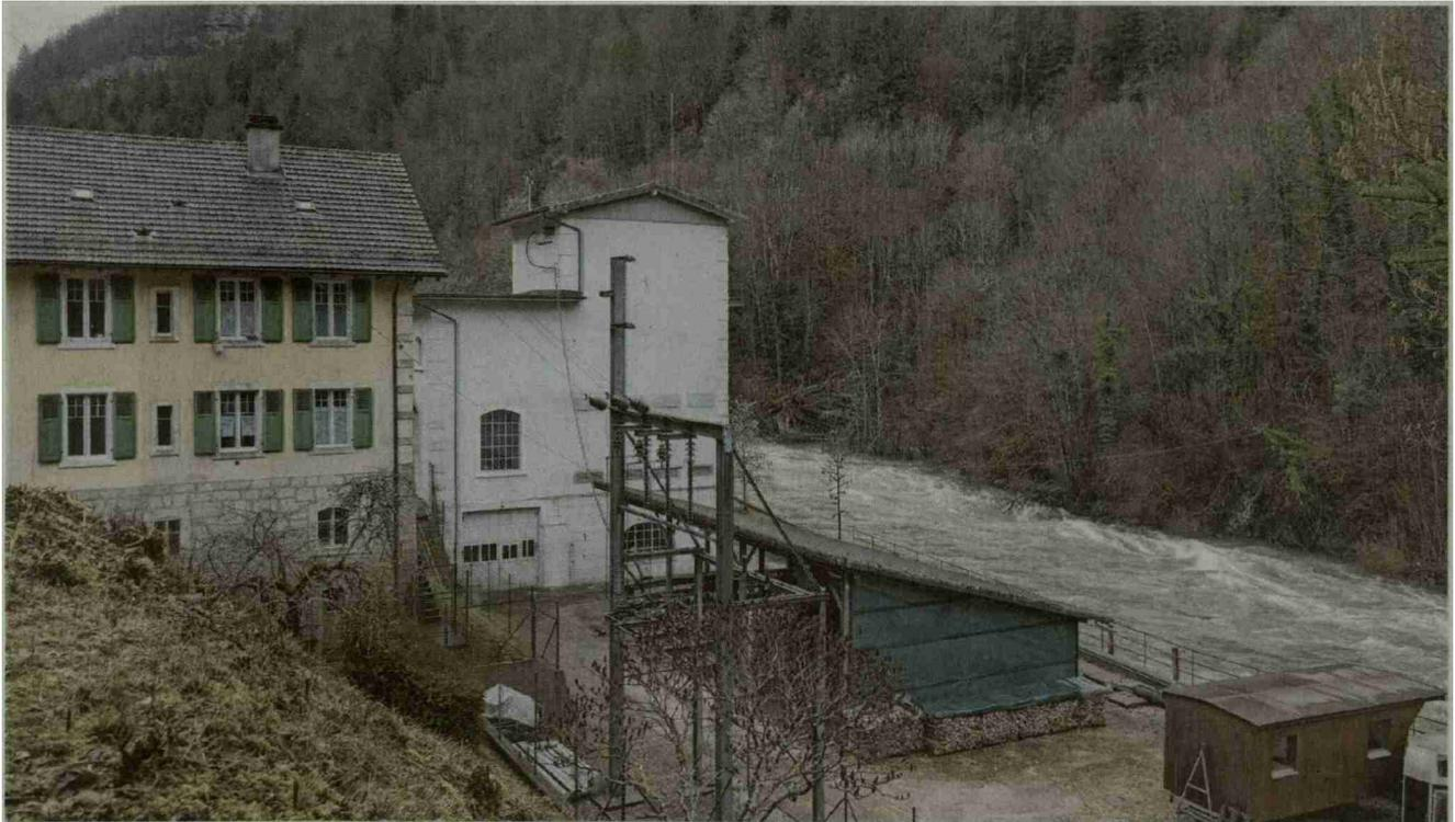
L'usine de La Goule, la route d'accès depuis Le Noirmont, les lignes électriques jusqu'à Saint-Imier et le canal d'amenée d'eau d'une longueur de 520 mètres ont vu le jour en un peu plus d'une année, en 1894.
