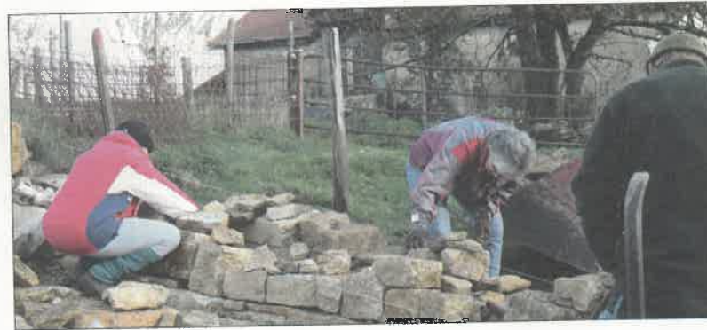
Après avoir pris le temps de répondre aux questions des journalistes invités vendredi sur le chantier, les deux apprentis muretières et leur maître se sont remises au travail. photo tl
