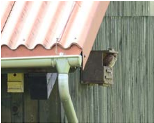
Nichoir à faucon crécerelle sur un bâtiment agricole. © M.Farine
