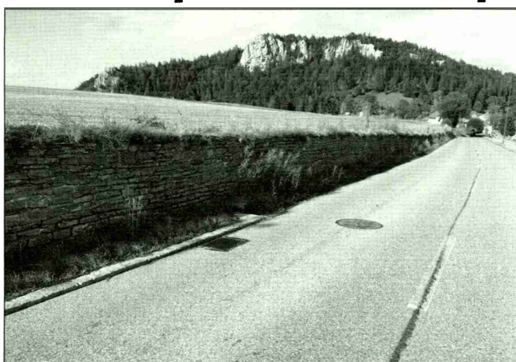
La construction de murs en pierres sèches: un métier d'artisan, un art et une science. (photo Idd)
