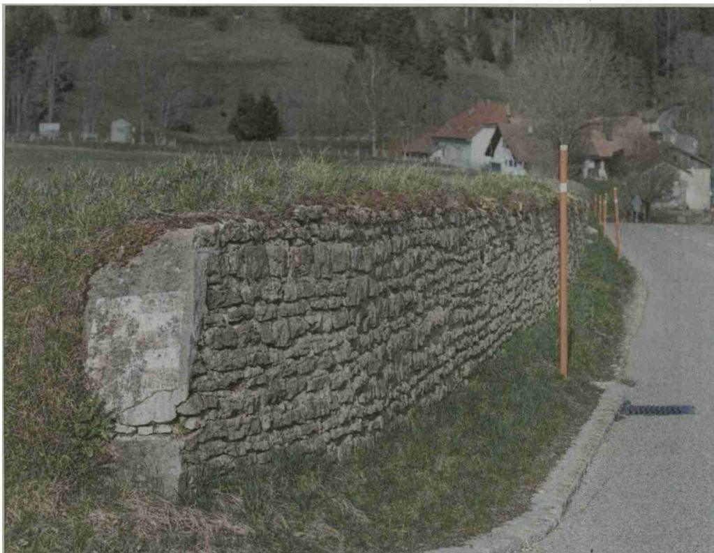
Un mur de soutènement sert à stabiliser le terrain.
