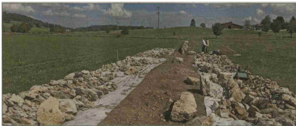
Les travaux de construction du mur par l'AJPS ont eu lieu à l'automne dernier.
