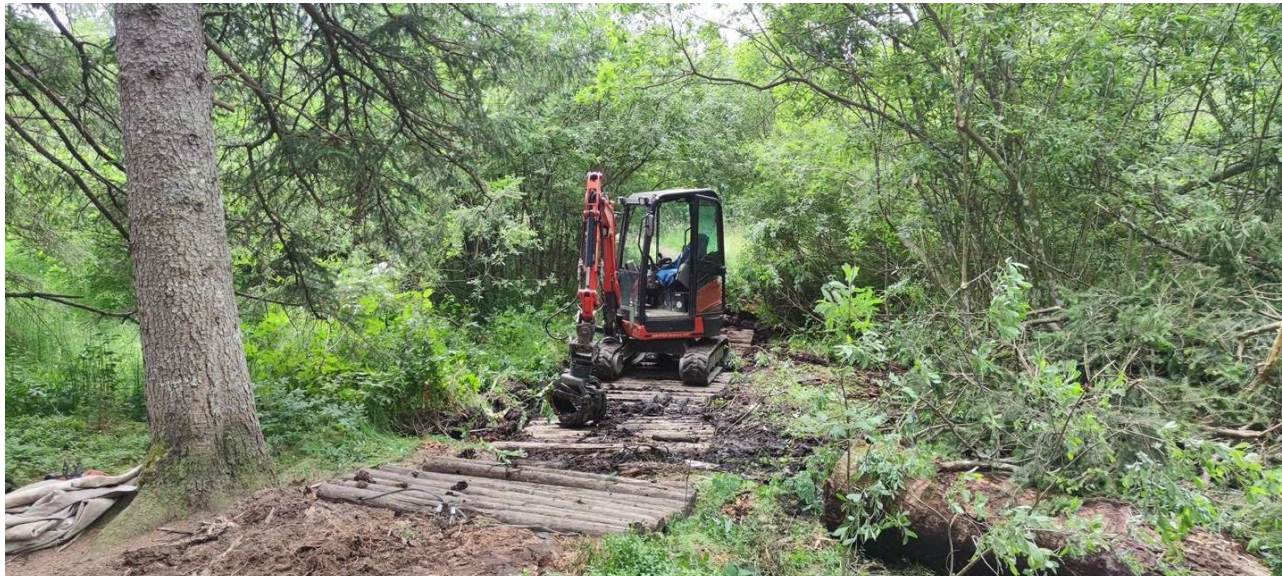
Des travaux urgents de sécurisation de 42 mètres de ponton sont en cours à l'étang de la Gruère Source: Parc du Doubs
