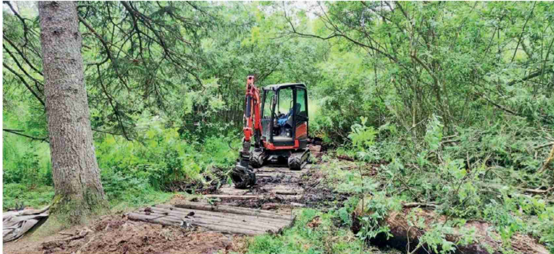
Am Etang de la Gruère werden dringende Arbeiten zur Sicherung von 42 Metern Steg durchgeführt.
