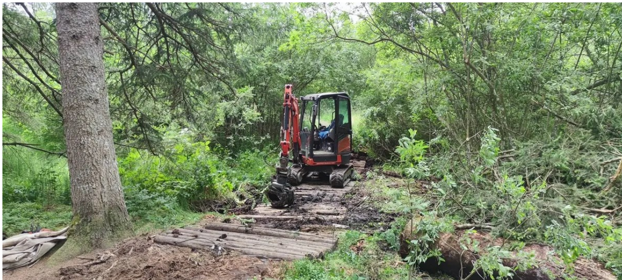
Am Etang de la Gruère werden aktuell dringende Arbeiten zur Sicherung von 42 Metern Steg durchgeführt. Foto: zvg/ Parc du Doubs
